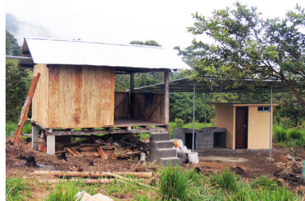
Neue Hütte mit Dusch-WC-Anlage
